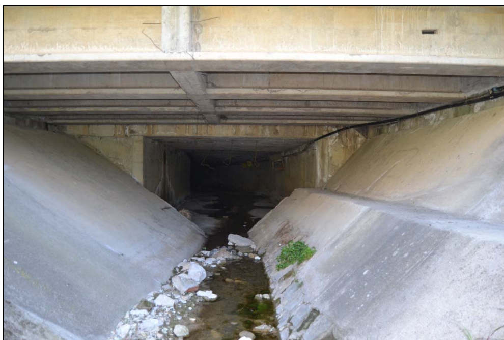
Foto 2: SC0015 - Vista da monte del ponte in cls che prosegue senza soluzione di continuità come tombinamento al di sotto della Via Umberto
