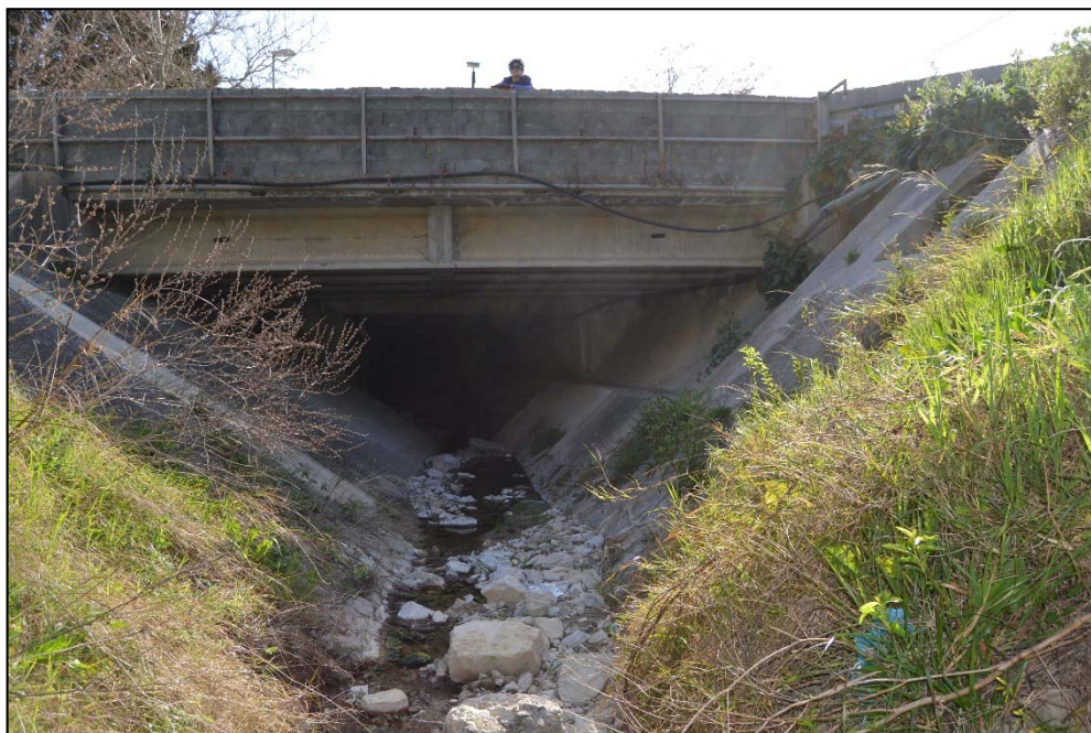
Foto 1: SC0015 - Vista da monte del ponte in cls che prosegue senza soluzione di continuità come tombinamento al di sotto della Via Umberto
